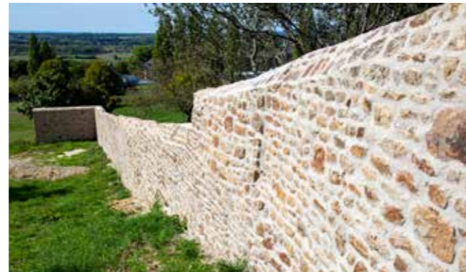
Sous le Jardin des plantes, le mur est reconstruit.
