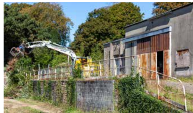
La réhabilitation du site de l'ancienne usine à gaz est lancée et se poursuivra ses prochains mois.
