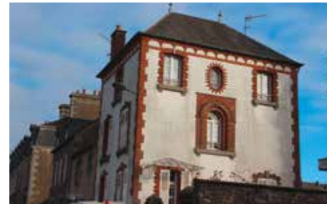
La brique s'imisce partout, dans les modénatures (les éléments de décoration tels corniches, bandeaux, moulure, etc.) ou appareillages, dans les enduits façon brique, jusque dans les souches de cheminées.
