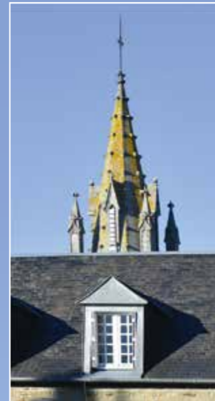
Toiture devant le clocher de l'église Saint-Saturnin.
