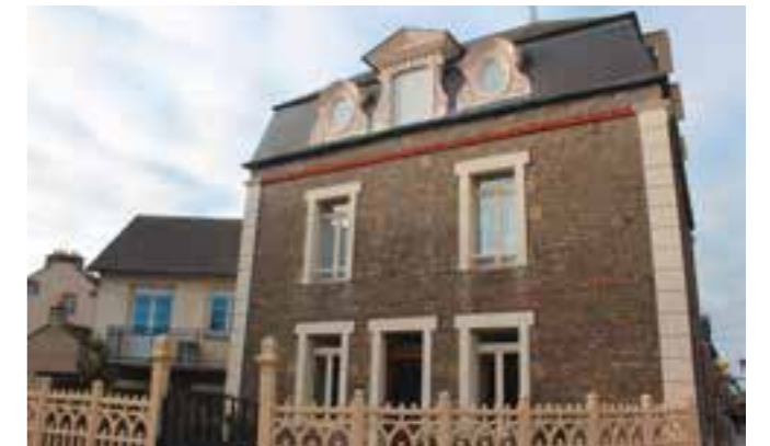
Immeubles Place Patton avec pierres en parement, angles pilastres et corniches en béton, avec apparition d'un nouveau type de chien assis carrés en béton armé
