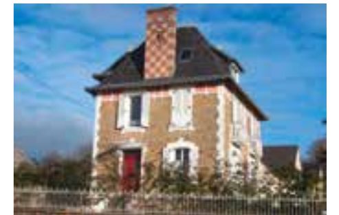
Un bel exemple de souche cheminées en brique.
