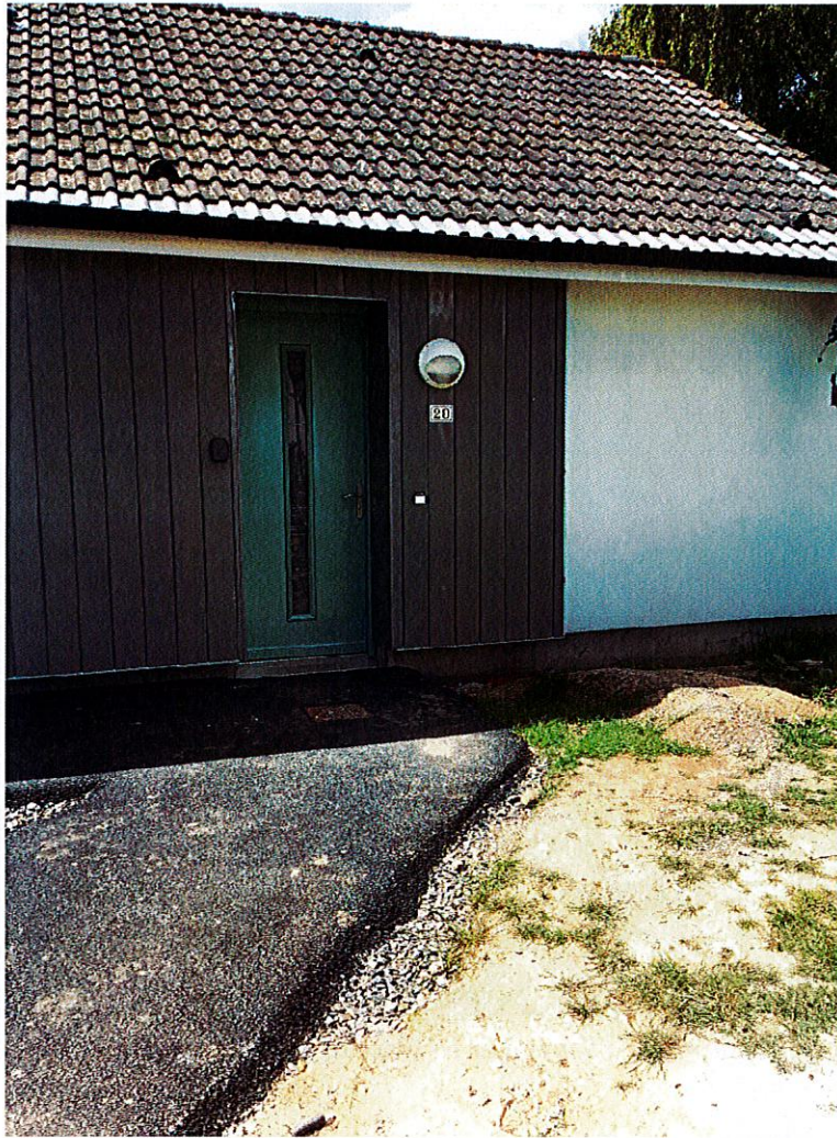
Vue du T2 issu de la grande chambre et d'une petite chambre... côté porte d'entrée ...
