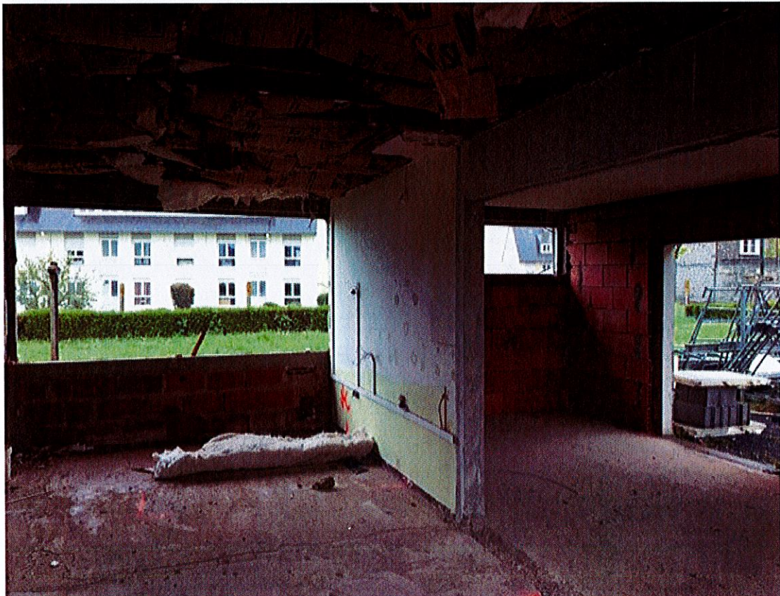
Démolition intérieure complète
