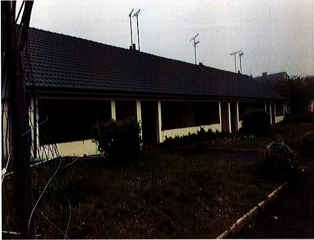
Les travaux se poursuivent par ailleurs avec les deux 1ers bâtiments situés à droite en entrant.
